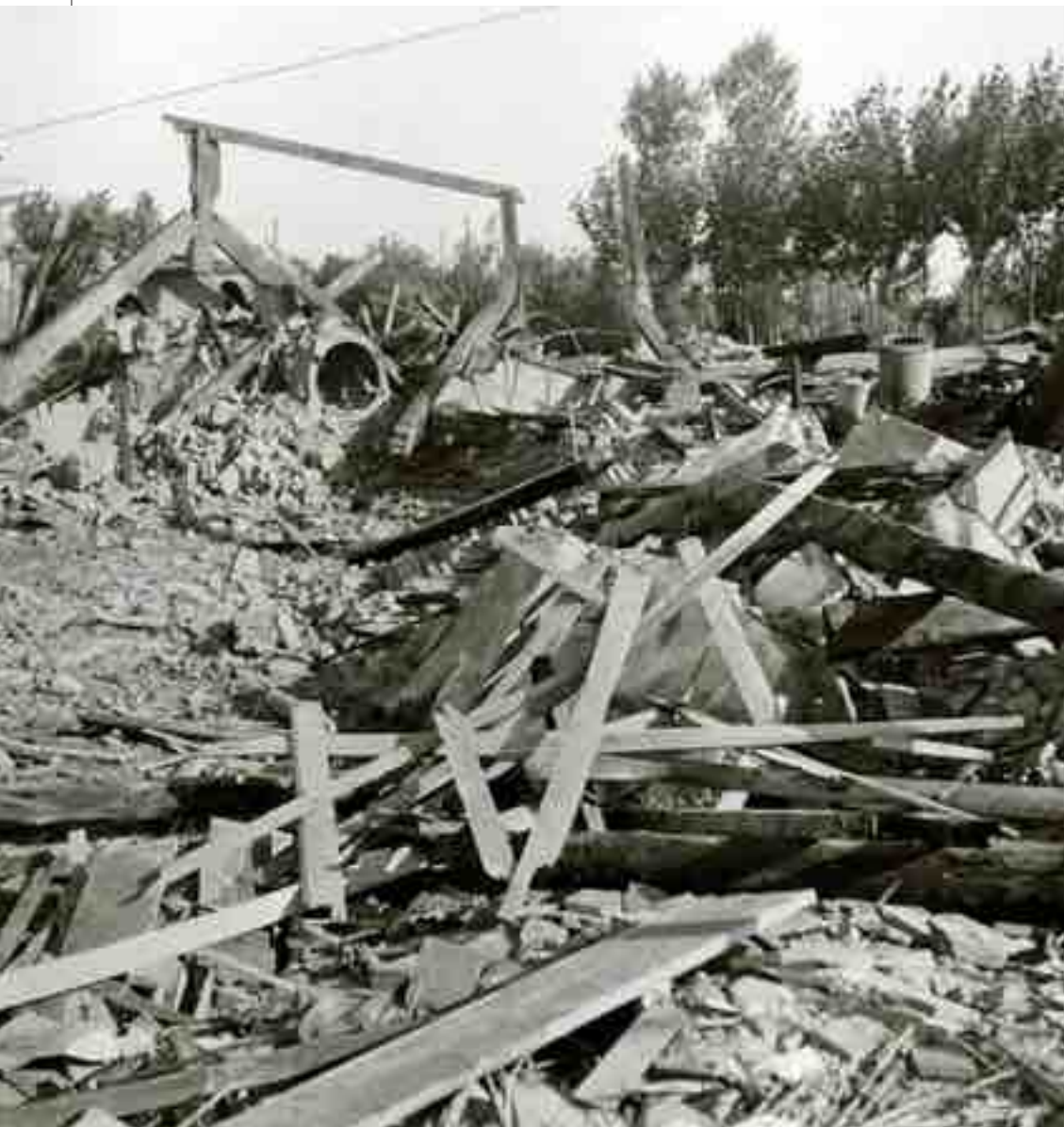
8 luglio 1944 - Sermide - quello che rimane del deposito locomotive e abitazione Capo Deposito Alfredo Ghiretti
