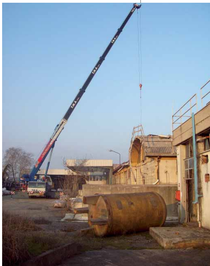
2011 Lavori di bonifica delle coperture eternit
