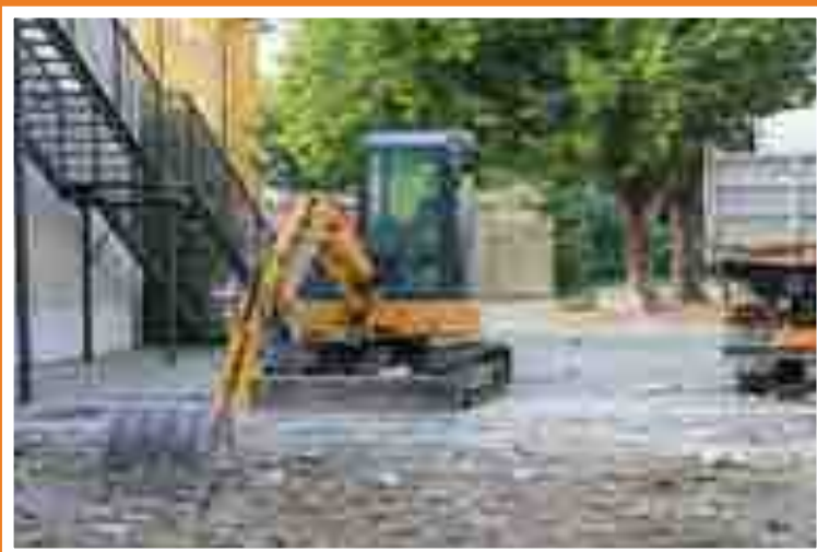
Lavori di ristrutturazione nel cortile delle Scuole Medie
