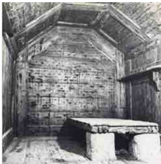
UNA CELLA DEI POZZI CON RIVESTIMENTO LIGNEO ORIGINALE
