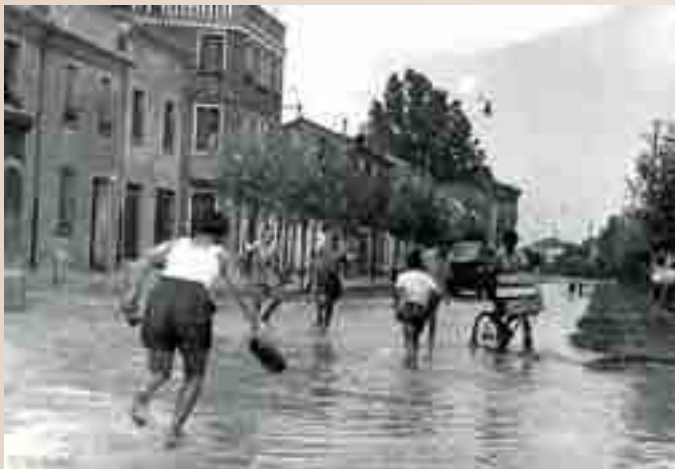
VIA 29 LUGLIO 1848 - LA FOSSA ALLAGATA
