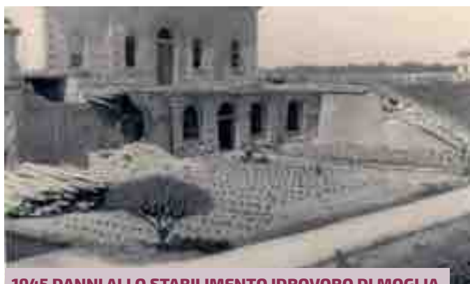
1945 DANNI ALLO STABILIMENTO IDROVORO DI MOGLIA
