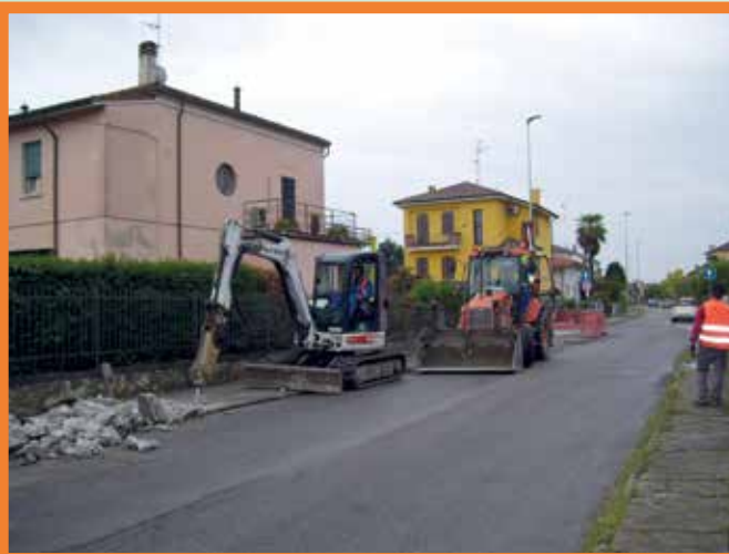
La foto ritrae l'escavatore col martello pneumatico durante la rimozione del vecchio marciapiede in cemento armato all'inizio di via Martiri di Belfiore.
