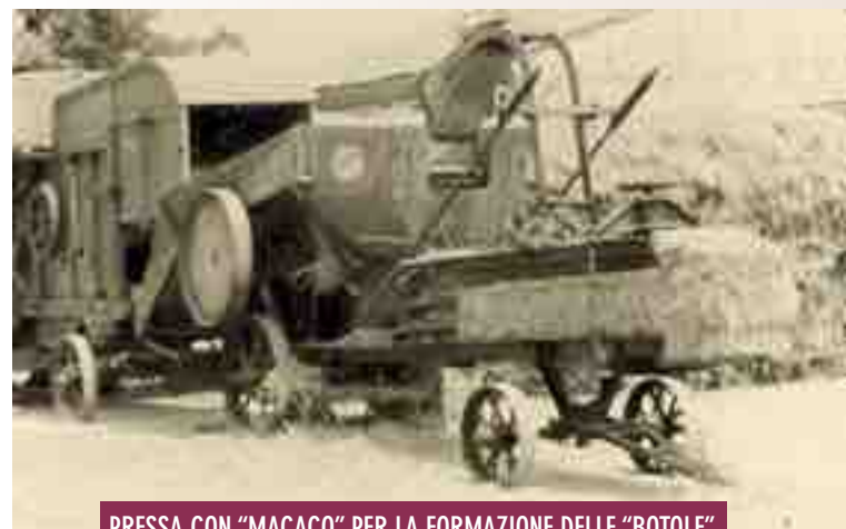
PRESSA CON "MACACO" PER LA FORMAZIONE DELLE "BOTOLE"
