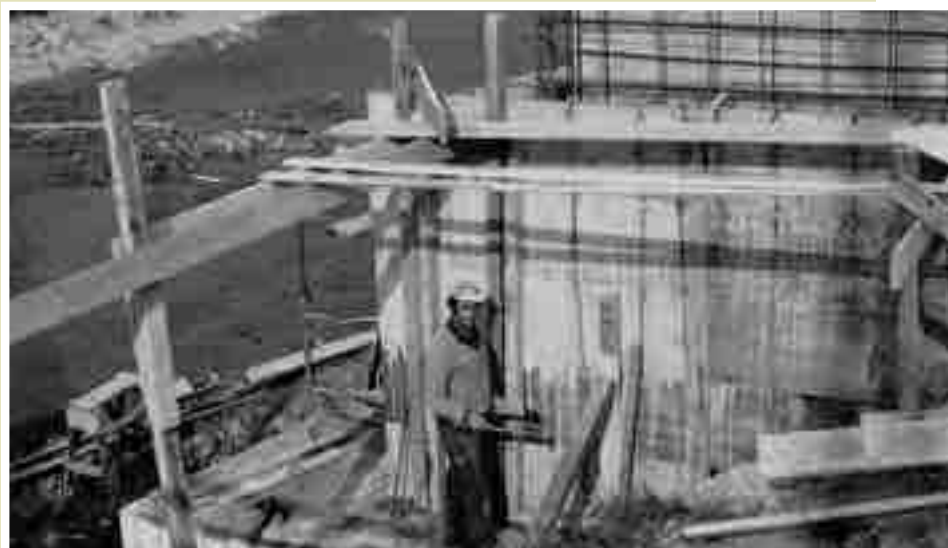
1983 Una fase di costruzione del nuovo ponte realizzato dalla Coop Edile Sermidese. Giordano Cavicchioli sta preparando una casseratura per c.a.
