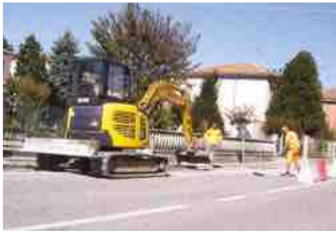
La foto ritrae la posa dei manufatti di cemento di delimitazione dell'allargamento della banchina
