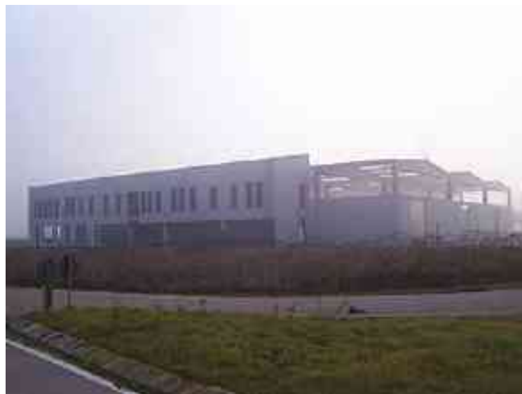
LA STRUTTURA ESTERNA E DI COPERTURA DEL COMPLESSO È STATA PORTATA A TERMINE, IN ATTESA DEL SUO COMPLETAMENTO CON LE ALTRE OPERE MURARIE ESSENZIALI
