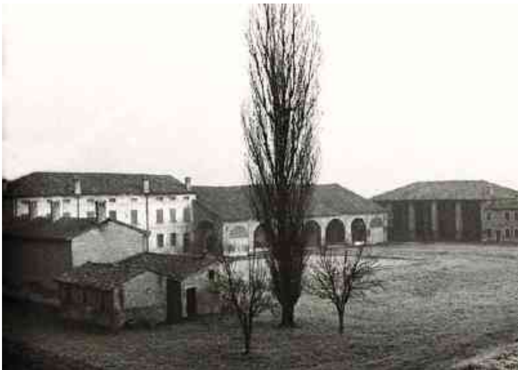
UNA TIPICA GRANDE CORTE RURALE DEL PRIMI ANNI '50, ZONA BASSA PADANA CON CASA E FABBRICATI
