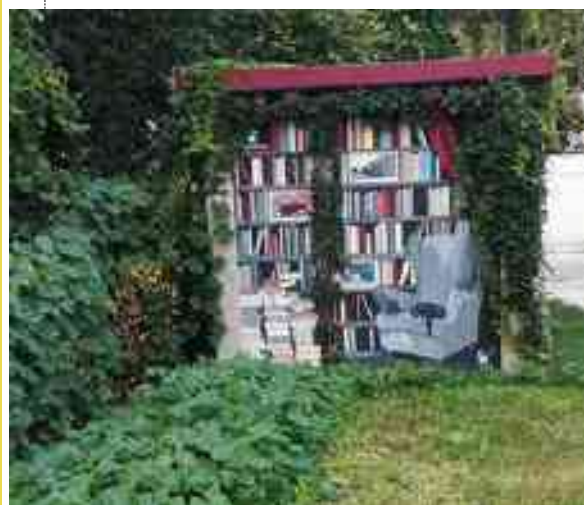
CABINA ENEL OGGI
