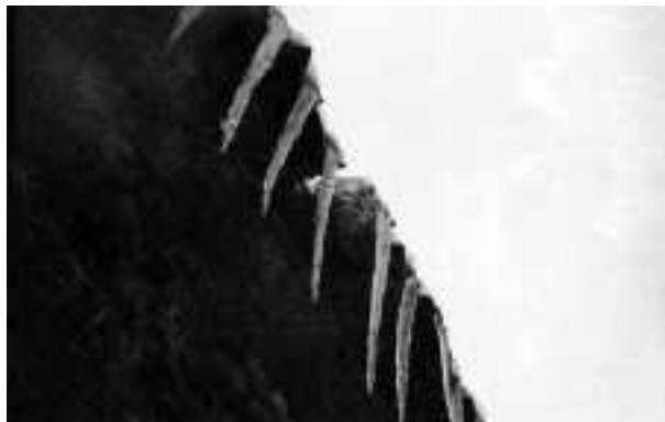
Sisurlòt (ghiaccioli) appesi ai coppi di copertura
