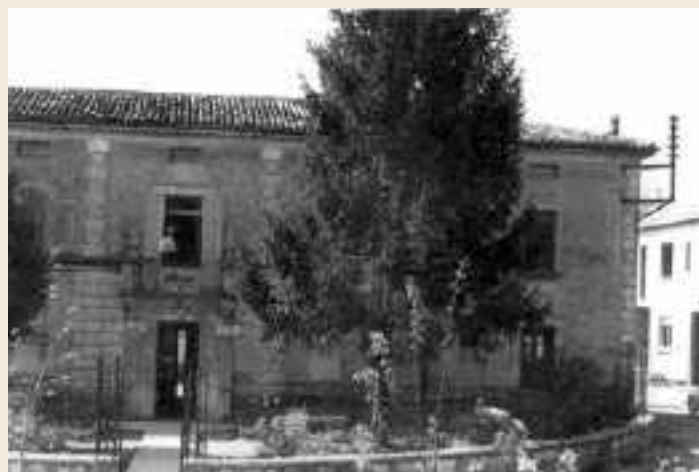
Sede storica della cooperativa tra via Nazario Sauro e vicolo Mastine
