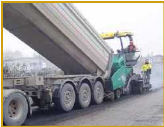
La macchina stenditrice mentre deposita il nuovo strato di asfalto
