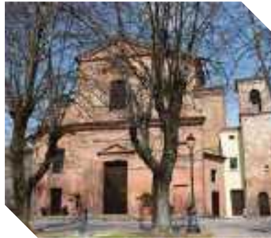
Facciata della chiesa della Natività della B.V. Maria riaperta, dopo gli eventi sismici del 2012, il 20/03/2022
