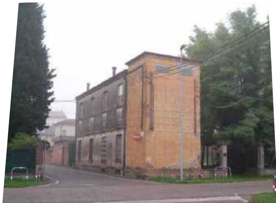
CABINA EX ENEL
