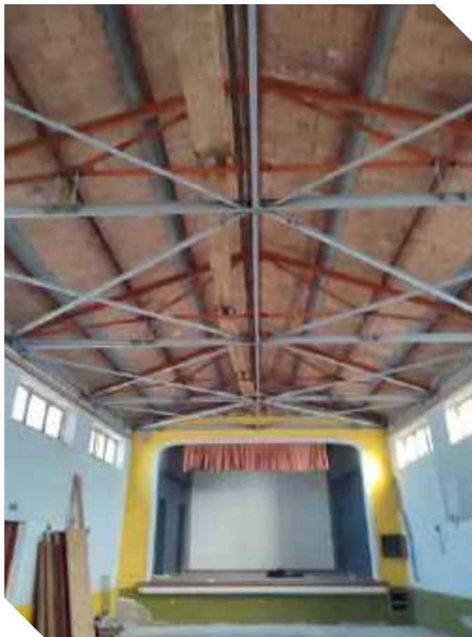
TEATRO DI MOGLIA-LAVORI INTERNI DI RIQUALIFICAZIONE FUNZIONALE
