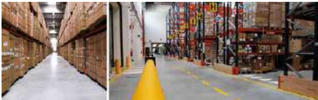
PAVIMENTAZIONE DI UN LOCALE DI LOGISTICA
