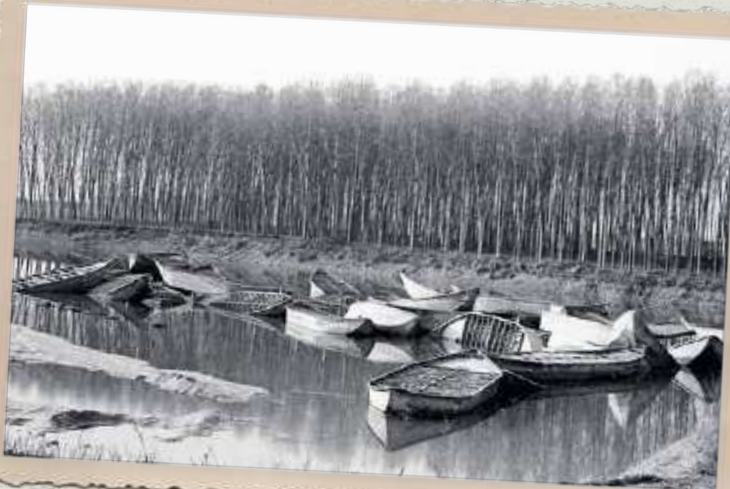
1972 Cimitero delle vecchie barche in cemento che sostenevano il ponte di legno fra Sermide e Castelnovo-Castelmassa
