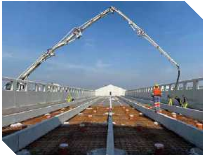
GETTO PAVIMENTAZIONE STALLA
