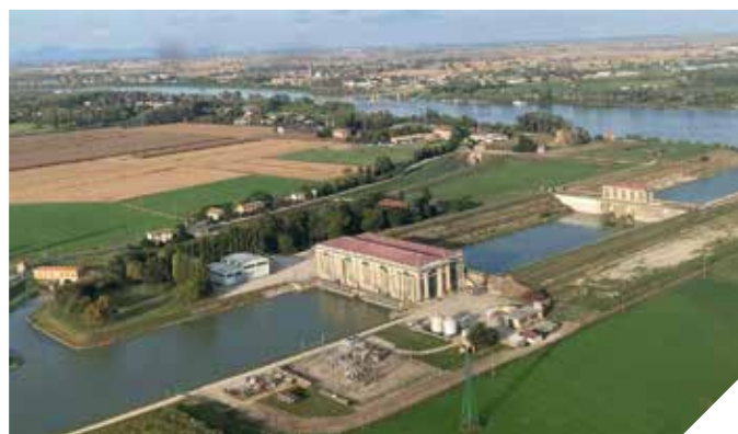
STELLATA: L'IMPIANTO DELLE PILASTRESI CHE VERRÀ POTENZIATO CON IL NUOVO IMPIANTO IDROVORO DENOMINATO "CAVALIERA". UN IMPIANTO DI SOLLEVAMENTO DI NUOVA GENERAZIONE CHE CONSENTIRÀ MAGGIORE SICUREZZA ED UN'EFFICIENTE GESTIONE DELLE ACQUE TRA LE PROVINCE DI MODENA, FERRARA E MANTOVA.
