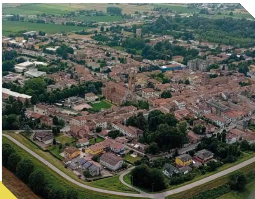
SERMIDE CON IL PARTICOLARE ANGOLO DELL'“ARGINELLO” E VEDUTA DELLA MAESTOSA CATTEDRALE NEL CONTESTO URBANO
