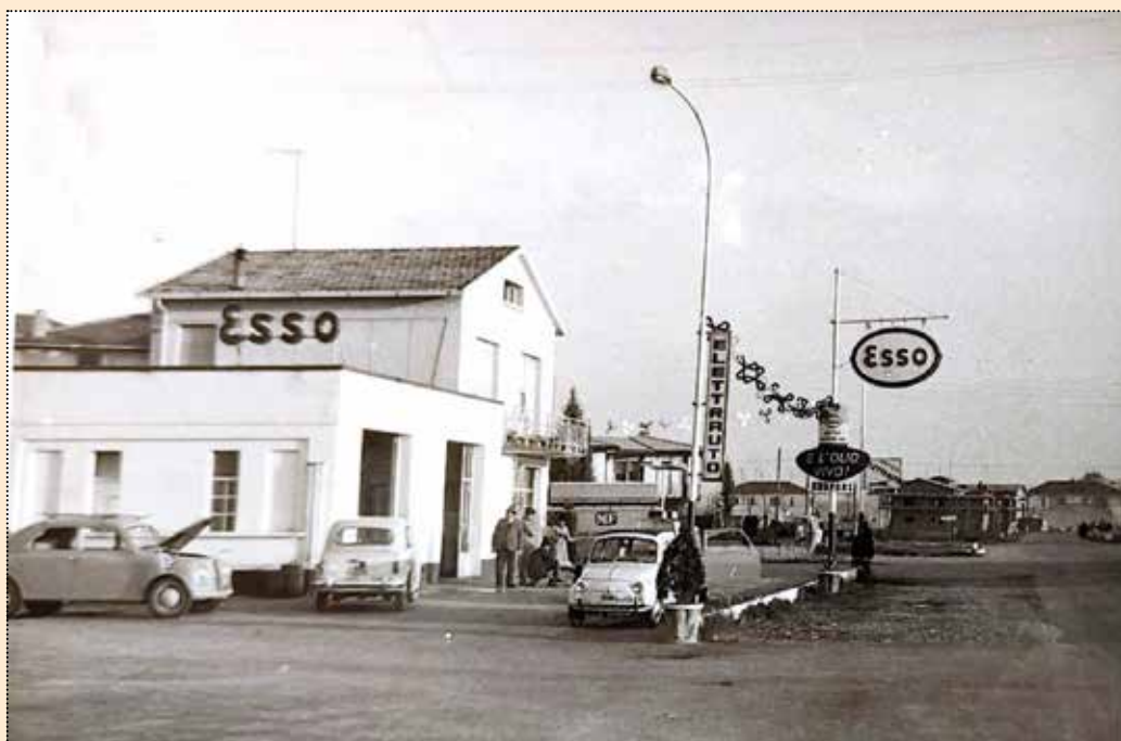
1965 Stazione servizio Esso Via Curiel
