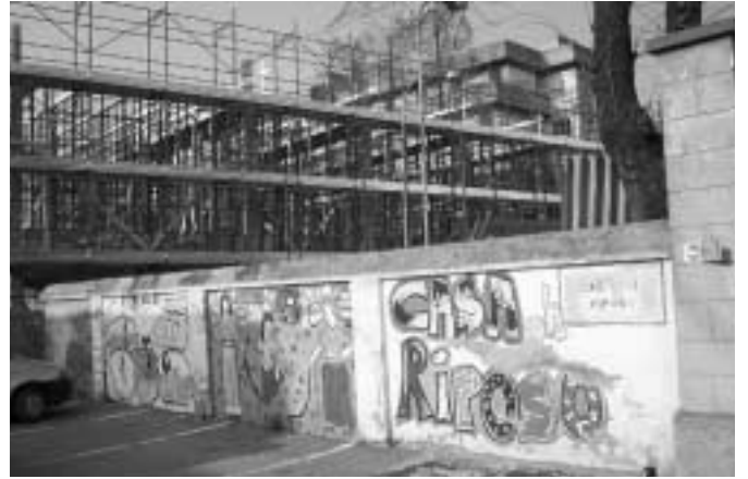
Continuano i lavori di ristrutturazione della R.S.A. di Sermide
