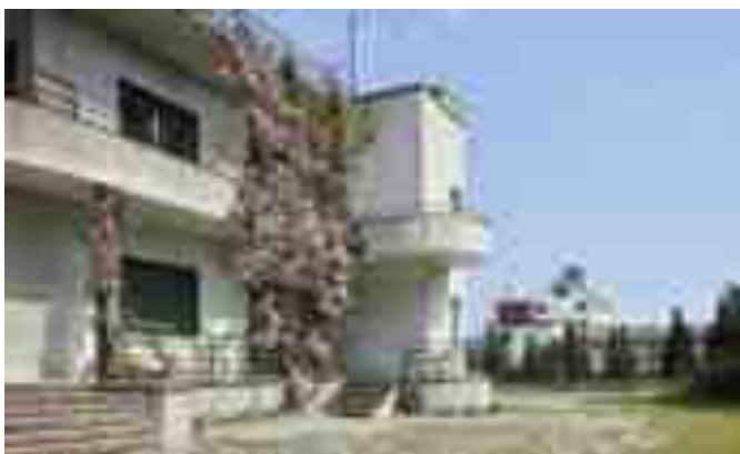
La villa progettata dall'architetto mantovano Zavarella
