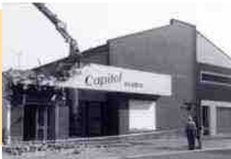
1997 Il "vecchio" Cinema Teatro Capitol - lavori di ristrutturazione
